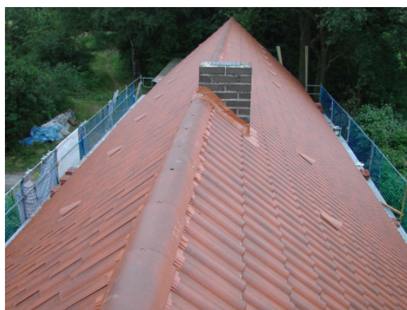
Das Dach ist dicht!
