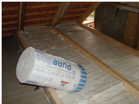
Das Dach wird in „Watte“ (URSA-Glaswolle) gepackt!
