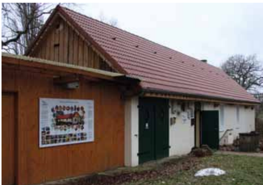
Abb. 2: Haus Wiesenstraße 21, Außenansicht Februar 2013
