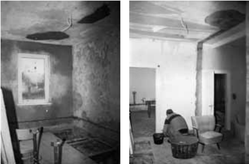
Abb. 1+2: Innensanierung des NABU-Hauses 1990 bis 1993 (Akten- und Gruppenraum)
