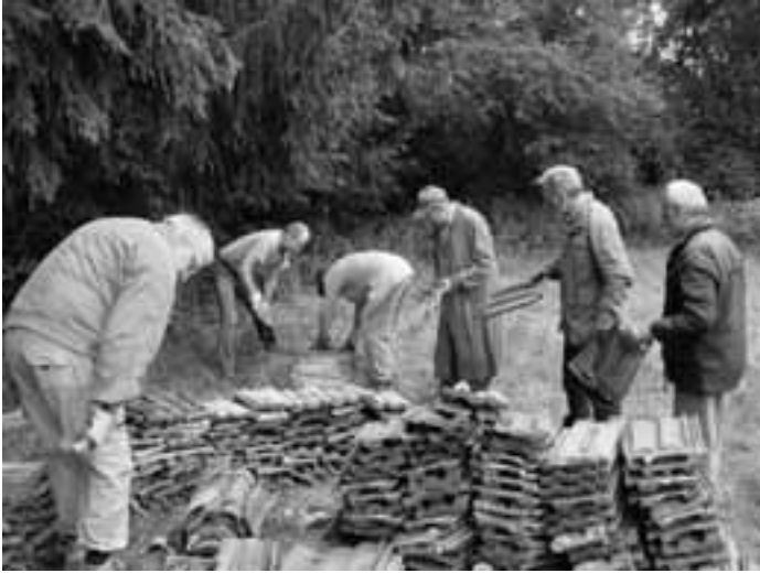
Abb. 8: Aus alten Dachpfannen entsteht eine neue Trockenmauer
