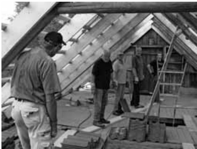
Abb. 10: Eine Menschenkette bringt neue Dachpfannen unters Dach
