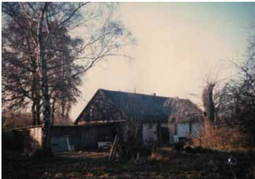
Abb. 1: Haus Wiesenstraße 21, Außenansicht um 1990
