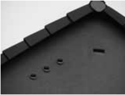
Spitzgiebel eines Wohnhauses mit Unterputzquartieren (3 Mauersegler-, 1 Fledermauskasten)
