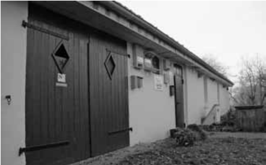
Nordseite des NABU-Hauses, frisch saniert
