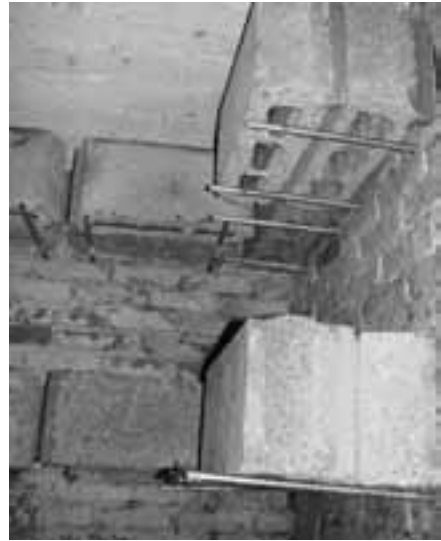
Hohlblocksteine als Winterquartier für Fledermäuse
