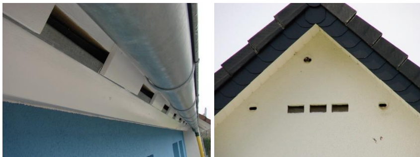
Abb. 3, 4: Traufkastenschlitze für Spatzen und Mauersegler (links); integrierte Mauersegler- und Fledermausquartiere (rechts; das obere Mauerseglerquartier wird von Spatzen bewohnt).
